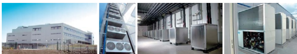
Rys. 13. Instalacja GHP AISIN w zakładzie produkcyjnym na Węgrzech. Układ GHP AWS 504 kW.
